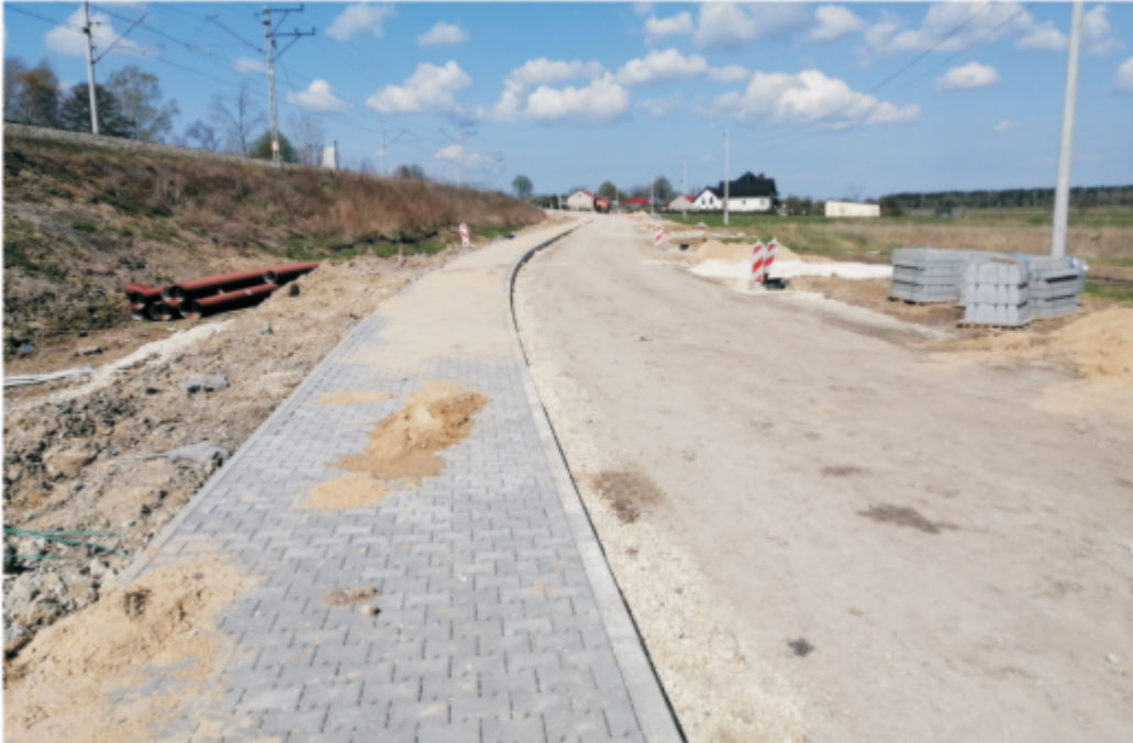
DROGA W TRAKCIE ROZBUDOWY
