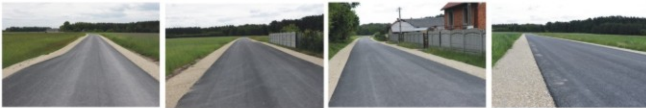
Droga w Jeżowicach po przebudowie
