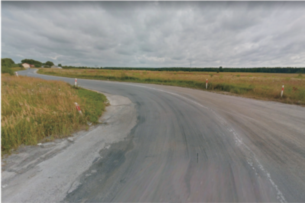
DROGA PRZED ROZBUDOWĄ
