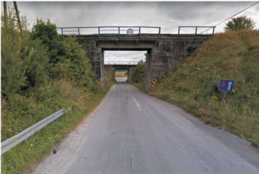
DROGA PRZED ROZBUDOWĄ
