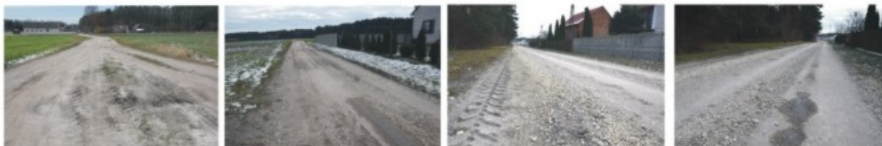
Droga w Jeżowicach przed przebudową
