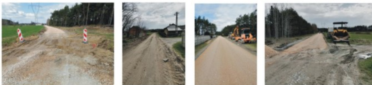
Droga w Jeżowicach w trakcie przebudowy
