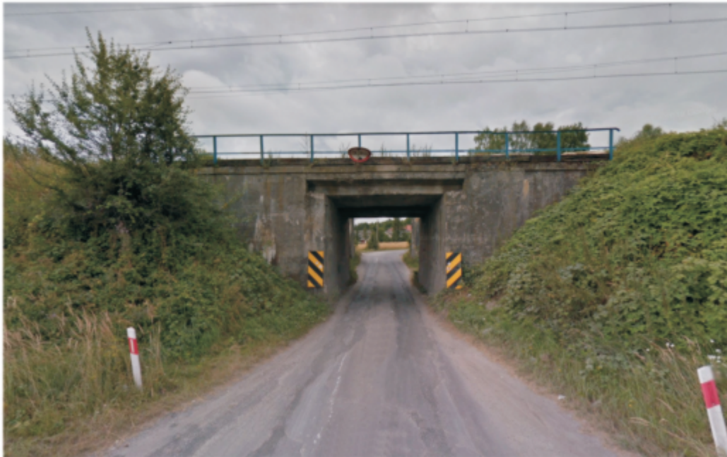
DROGA PRZED ROZBUDOWĄ
