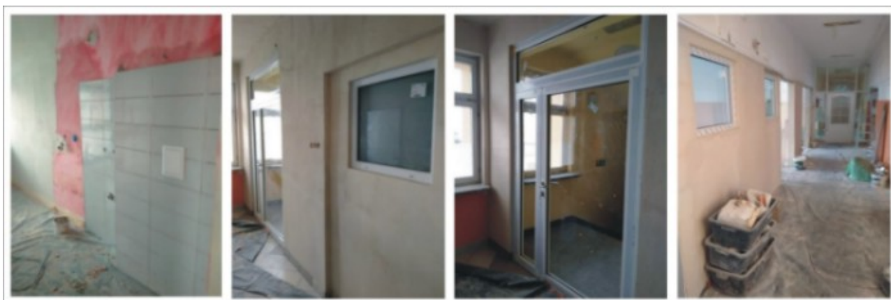
Oddział Hospicjum Stacjonarnego ZOZ we Włoszczowie w trakcie remontu
