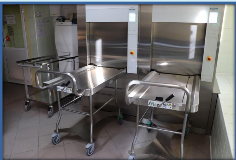
Centralna Sterylizatornia po remoncie
