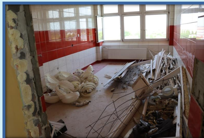
Oddział Chirurgii Ogólnej w trakcie przebudowy – 2021 i 2022 r.
