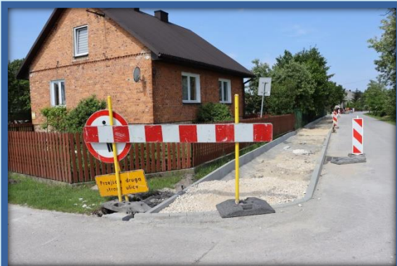
Wizytacja postępu prac na budowanym chodniku w Tarnawej Górze – 6 czerwca 2022 r.
