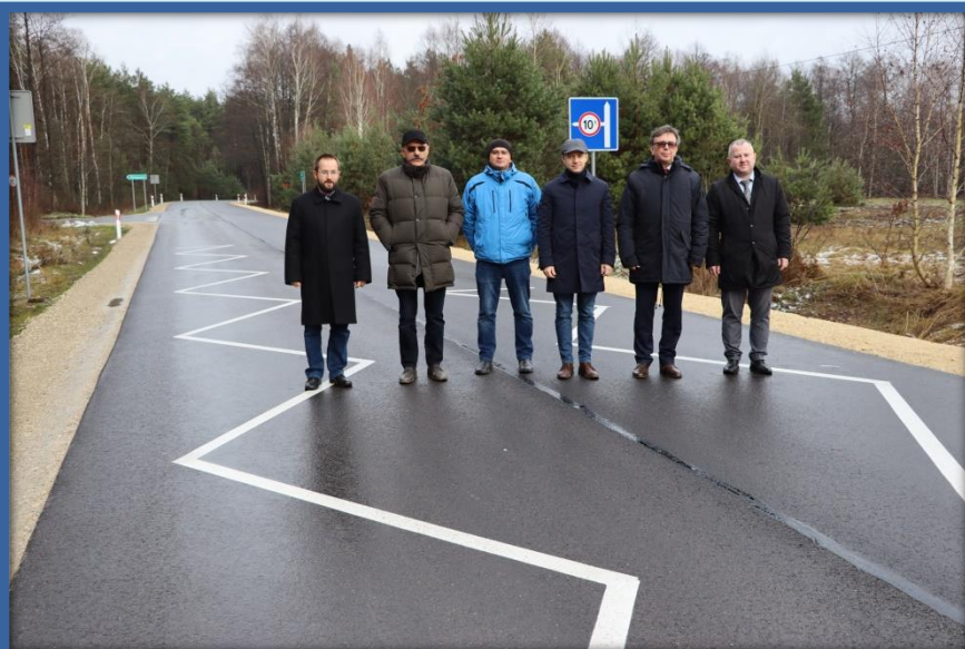
Odbiór przebudowanej drogi powiatowej Nr 1442T na odcinku Biadaszek – Włoszczowa – 7 grudnia 2022 r.
