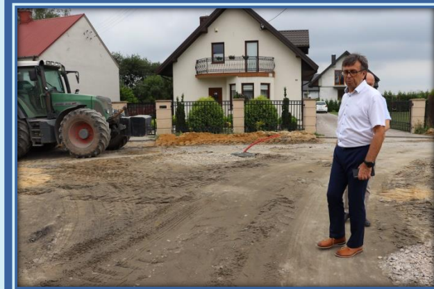
Wizytacja postępu prac na rozbudowywanej drodze – 2 sierpnia 2022 r.
